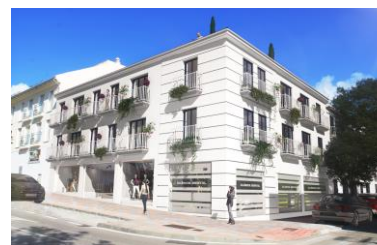
Las Salinas Homes, Málaga
